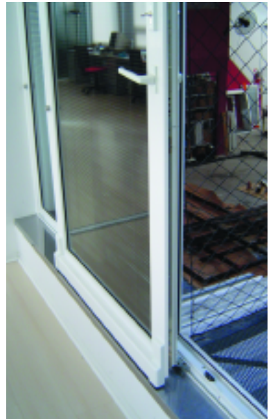
Figura 8: corredera paralela (gentileza de Next Windows)
